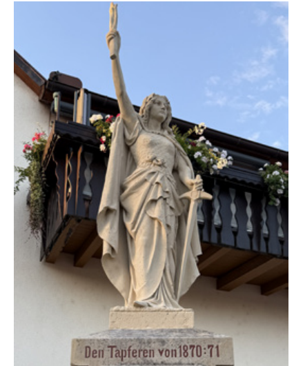
Das Kriegerdenkmal in Aubstadt ist wieder grundlegend saniert. Foto: Hanns Friedrich
