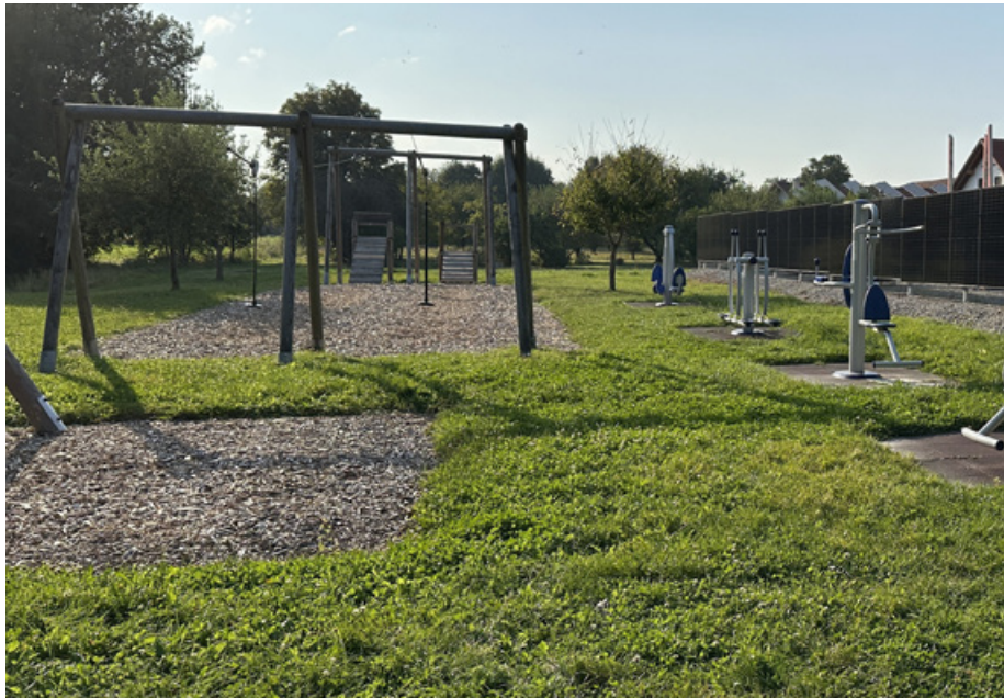
An den Kinderspielplätzen in Aubstadt sind nur wenige Mängel bei der Jahreskontrolle aufgefallen. Die Hackschnitzel, welche als Fallschutz dienen, müssen z. B. erneuert werden. Foto: Hanns Friedrich
